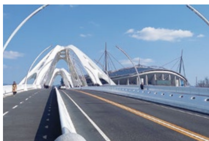
豊田スタジアムと豊田大橋（豊田市）
