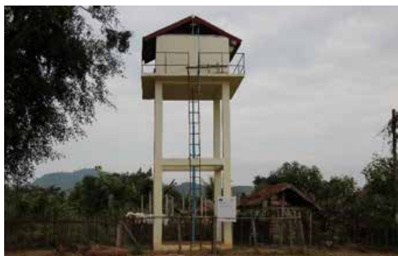
給水塔（名古屋東山 RC）
