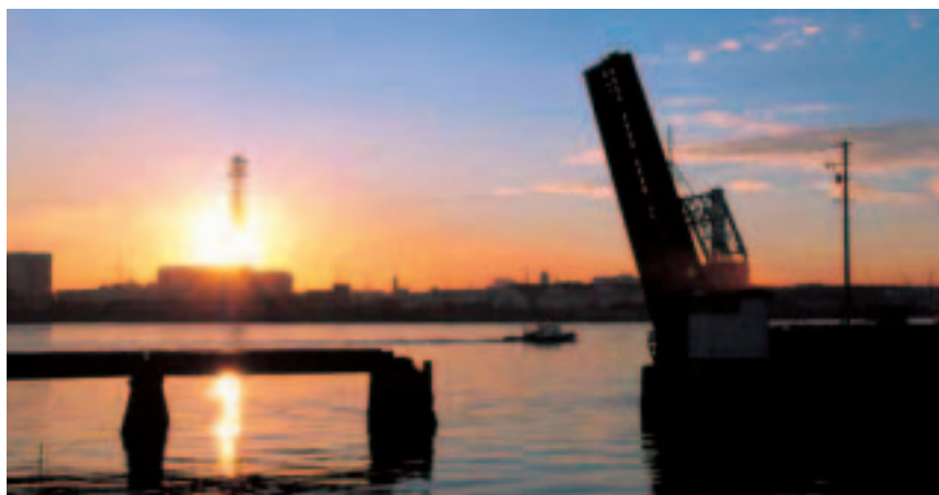
▲名古屋港 跳ね上げ橋
