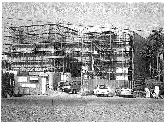
1997年11月現在 建設状況
