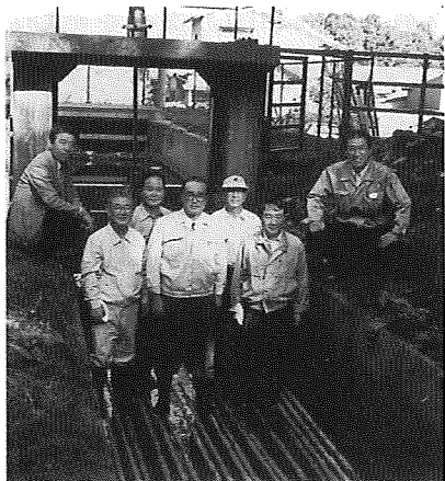
バイオコード設置
