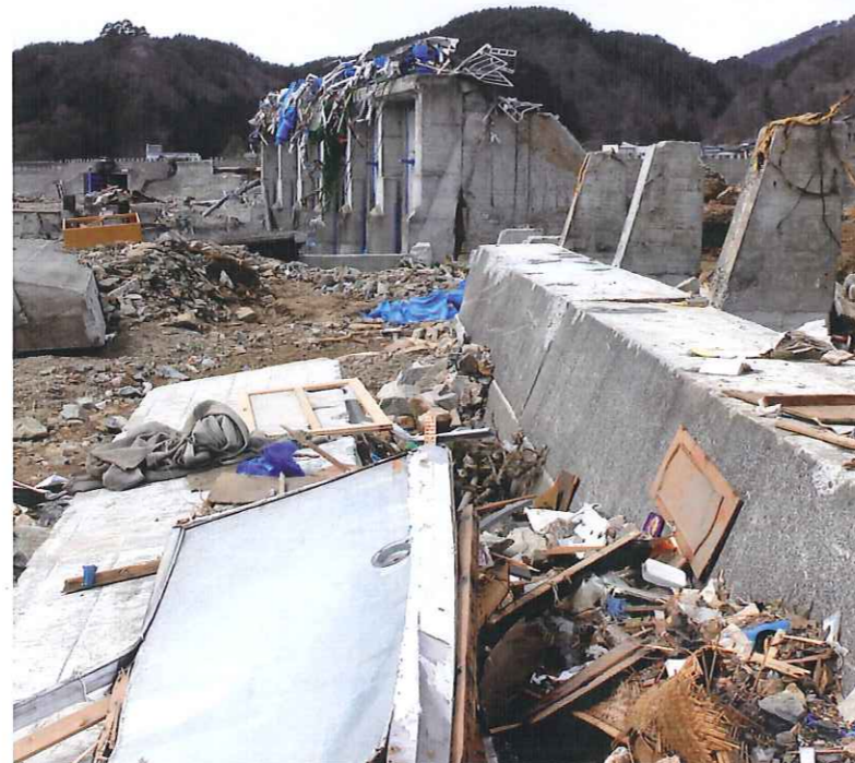
「崩壊した防波堤の塊が散乱し、水門だけがわずかに残る」宮古市田老町（岩手日報社提供）
