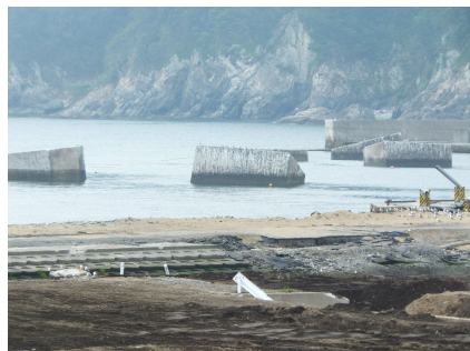
流された防波堤
