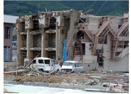
横転したビル
