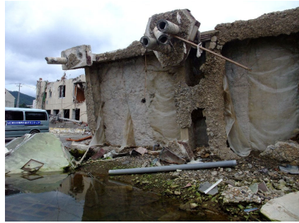
パイルごと抜かれている
