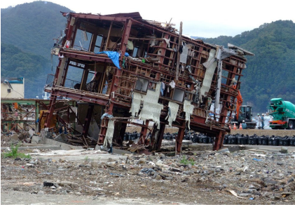
傾いた鉄骨建物
