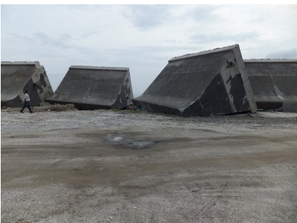
押し倒された防潮堤
